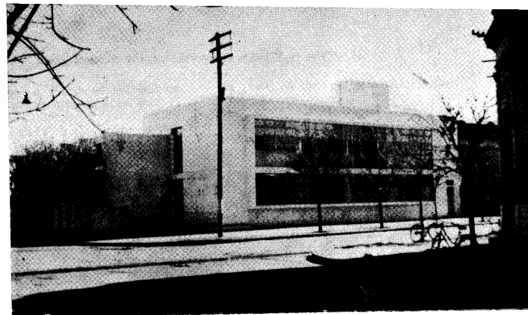
Fig. 1. Frente del edificio de la Zona VIII
