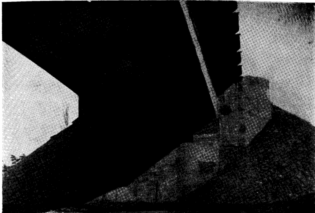
Fotografía 3—Ambas vigas huecas, rigidizadas transversalmente mediante diafragmas, de los cuales la foto muestra el último, rematan sobre los estribos en sendas articulaciones pendulares de hormigón armado, que sustituyen a los clásicos rodillos de acero. Pueden además, apreciarse los detalles del estribo, aletas y escollero.
