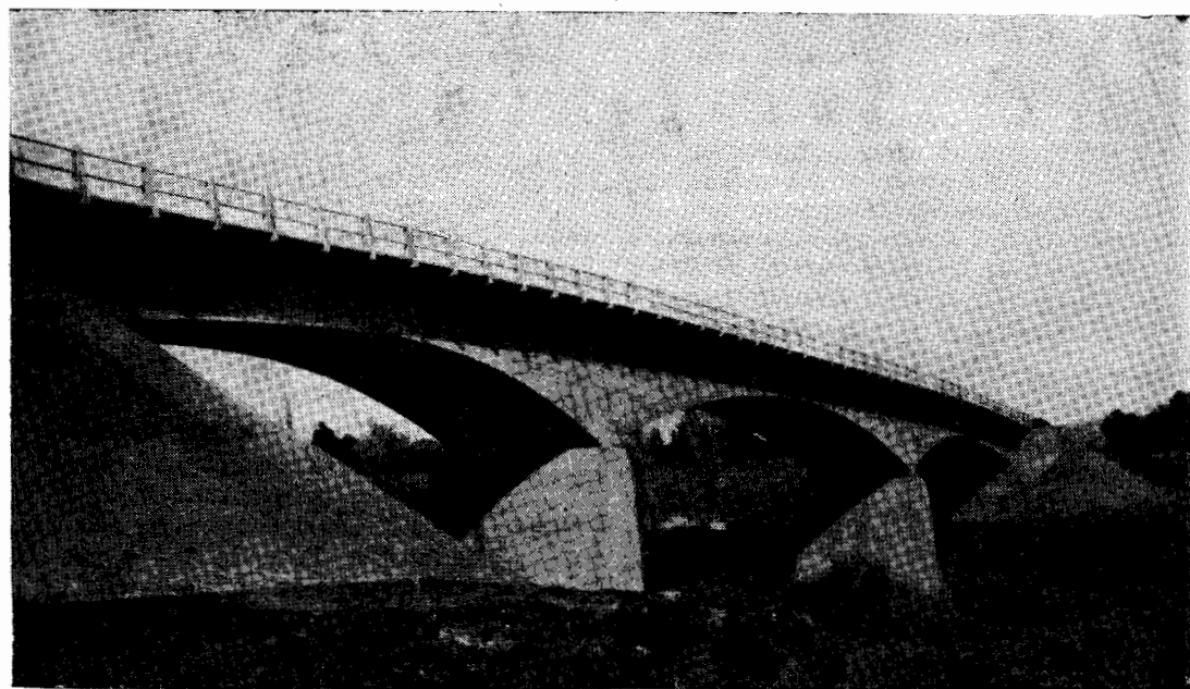
Fotografía 4— El pilar que aparece en primer plano aloja dos articulaciones pendulares de hormigón armado similares a las de los estribos; el segundo pilar constituye el apoyo fijo también de hormigón armado.
